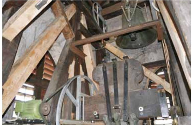
Der gesamte Glockenstuhl wurde verstärkt. Die neu eingefügten Elemente aus Lärchenholz sind an der helleren Farbe erkennbar.
