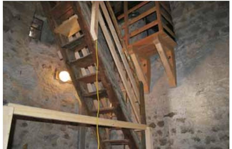
Der Stiegenaufgang im Turm ist nun wesentlich sicherer. Im Hintergrund sieht man den Zugang zum Kirchengewölbe, der nun über eine Aluminiumleiter und ein kleines Podest führt.
