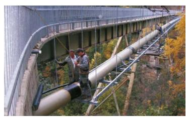
Beim Bau der E-Werke mussten mehrere technische Herausforderungen bewältigt werden, wie z.B. der Bau einer Rohrseilbrücke über die Masulschlucht.
