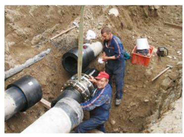
Dank der Erfahrung einheimischer Firmen im Kraftwerkbau konnten für alle technischen Schwierigkeiten gut durchdachte Lösungen gefunden werden. Im Bild der Einbau einer dehnbaren Rohrverbindung.
